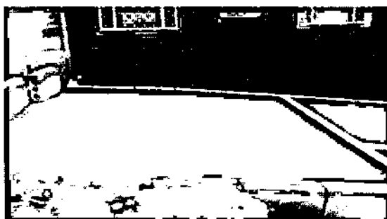
Ilustración 29. Conformación de Andenes en Terrazas con Bordillo A-80 y Subbase Granular Peatonal en el Barrio Altamira
