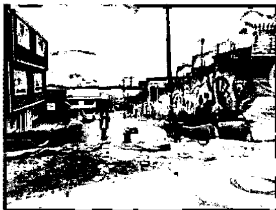
Ilustración 28. Instalación de Sardineles A-10 para Confinamiento de Vía en el Barrio Altamira
