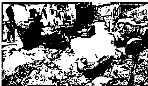
Ilustración 27. Excavación Mecánica de Roca en el Barrio Altamira
