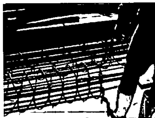
Ilustración 21. Hierro para Pilotaje en el Barrio Guacamayas
