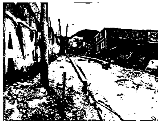
Ilustración 28. Instalación de Sardineles A-10 para Confinamiento de Vía en el Barrio Altamira
