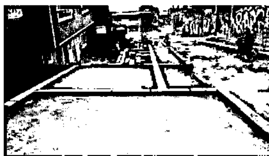
Ilustración 29. Conformación de Andenes en Terrazas con Bordillo A-80 y Subbase Granular Peatonal en el Barrio Altamira
