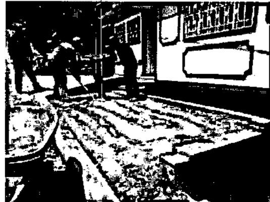
Ilustración 24. Compactación de Subbase Granular Peatonal en el Barrio Quindío
