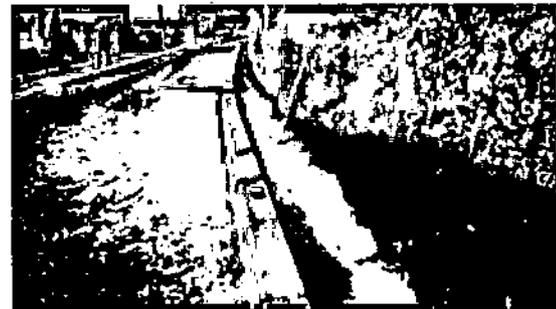
**Ilustración 8. Subbase Granular Peatonal en Andenes y Cunetas en el Barrio Guacamayas**
