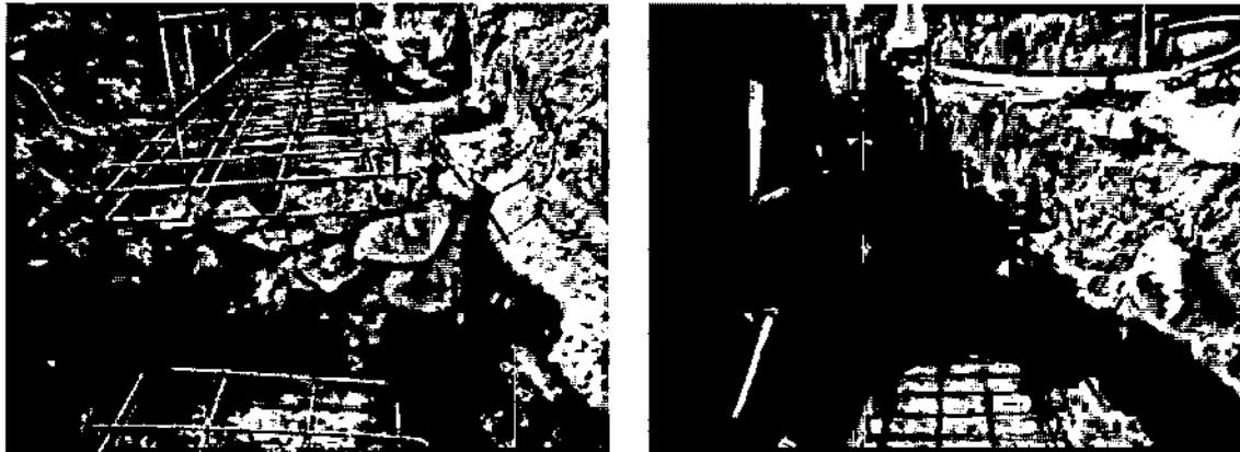
**Ilustración 2. Concreto Cielópeo para Muros en el Barrio Guacamayas**
