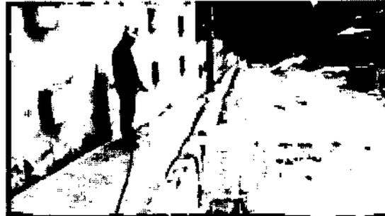
**Ilustración 16. Curado de Cunetas de Concreto en el Barrio Guacamayas**
