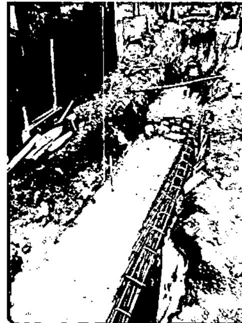
**Ilustración 25. Excavación, Concreto Ciclópeo y Acero de Refuerzo en Muros del Barrio Guacamayas**
