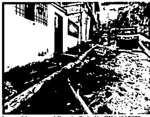
**Ilustración 10. Excavación Manual y Acero de Refuerzo Muros en el Barrio Quindío CIV 4007972**
