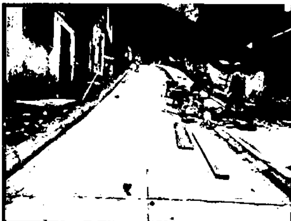
Ilustración 36. Instalación Adoquín en Arcilla de 20x10x6 cm CIV 4007972
