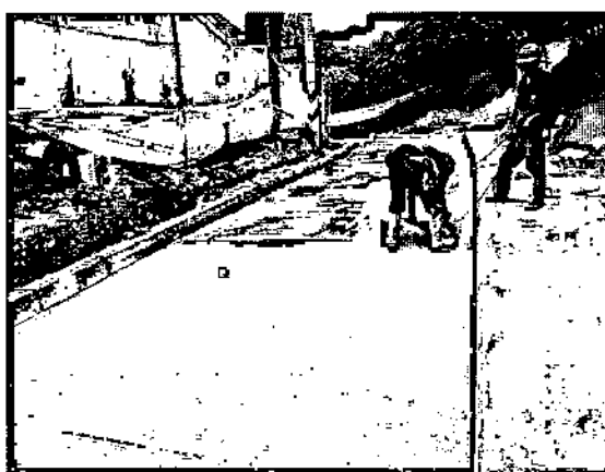
Ilustración 39. Corte de Losas MR-45 CIV 4007972
