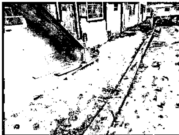
Ilustración 25. Subbase Granular Peatonal Andenes CIV 4007971
