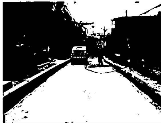
Ilustración 33. Compactación Subbase Granular Clase C CIV 4007972
