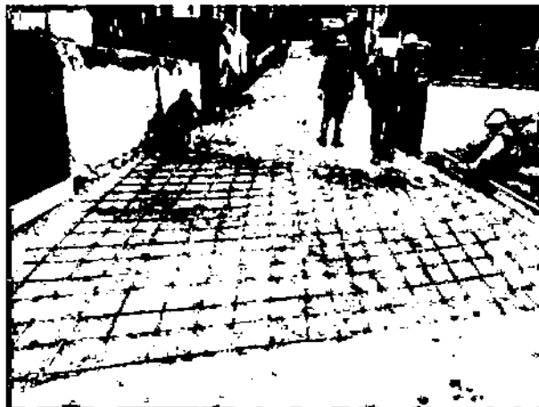
Ilustración 9. Acero de Refuerzo Rampa y Empalme Vía CIV 4005073
