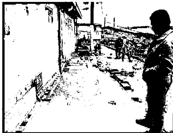
Ilustración 27. Instalación de Adoquines de Arcilla 20x10x6 cm CIV 4007971
