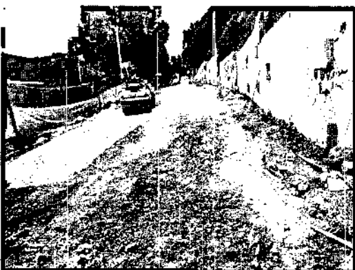
Ilustración 43. Compactación de Subbase Granular Clase C en el Barrio Guacamayas
