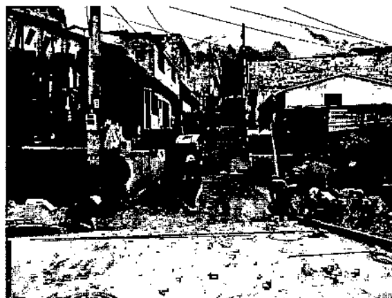
Ilustración 8. Nivelación y Compactación de Subbase Granular Clase C CIV 4005073
