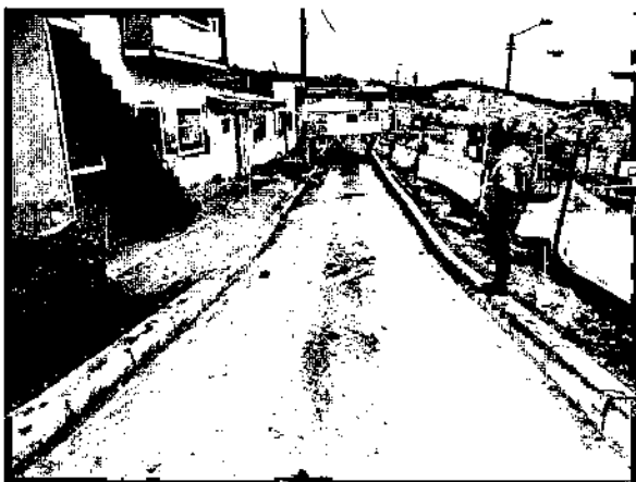
Ilustración 25. Subbase Granular Peatonal Andenes CIV 4007971
