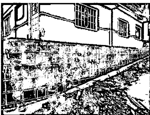
Ilustración 28. Acero de Refuerzo Muros CIV 4007971
