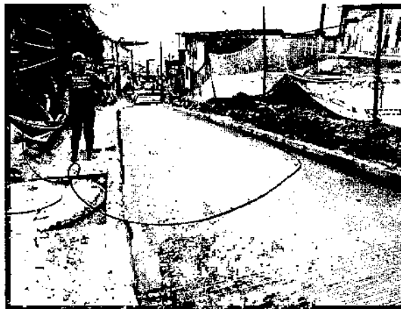
Ilustración 38. Curado de Losa MR-45 CIV 4007972
