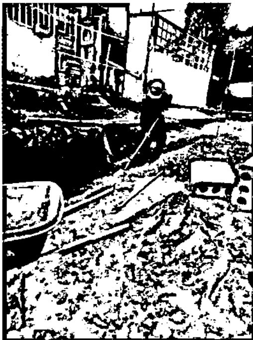
Ilustración 42. EXCAVACION MANUAL PARA INSTALACION DE SARDINELES A-10 CIV 4007972
