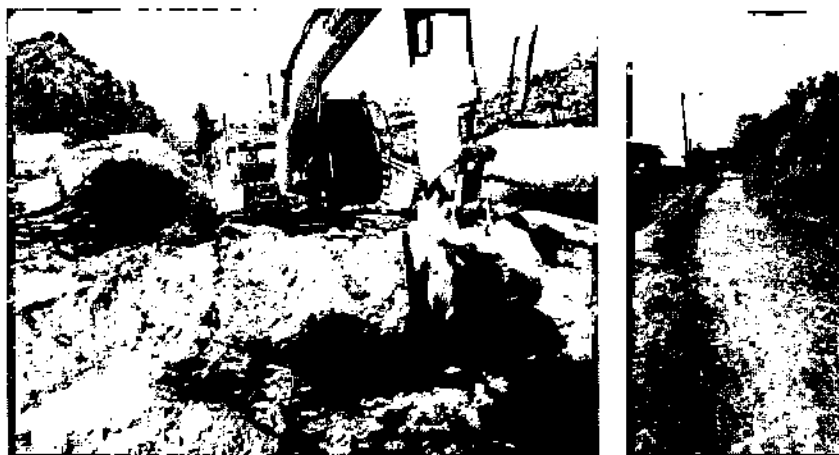
Ilustración 18. EXCAVACION MECANICA BARRIO GUACAMAYAS
