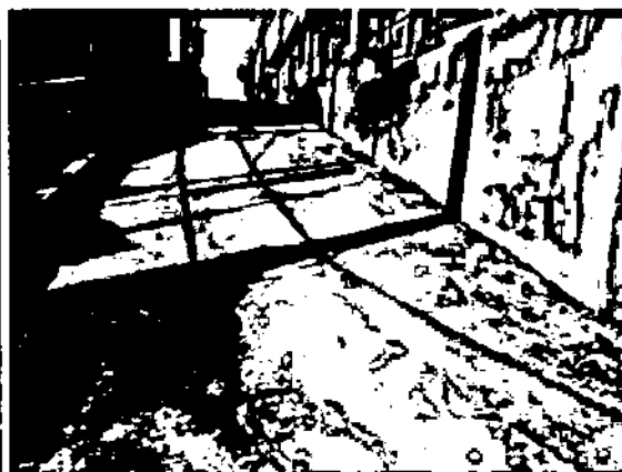
Ilustración 12. FUNDIDA VIA CON CONCRETO MR45 CIV 4005352
