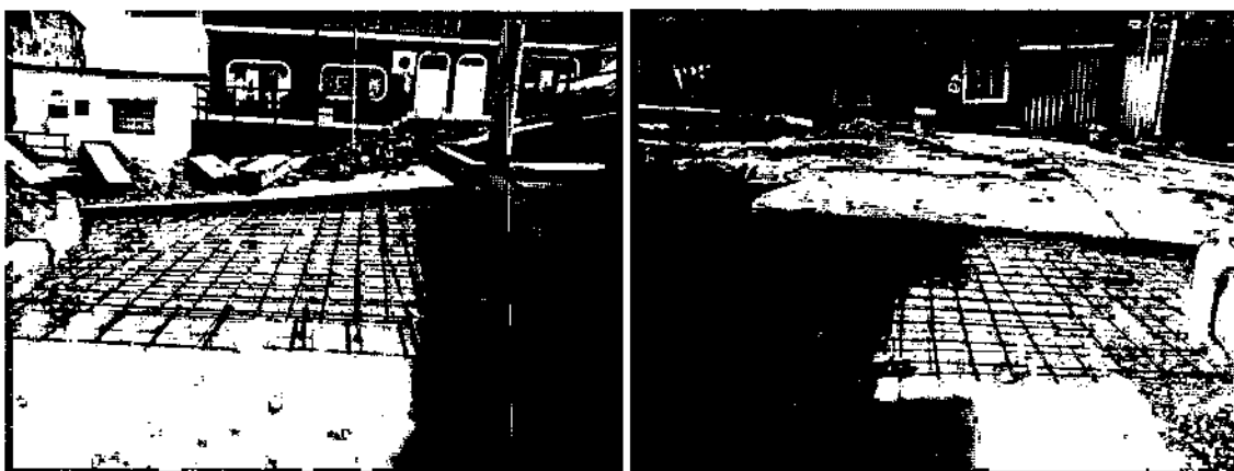
Ilustración 30. REFUERZO EN EMPALMES CON VIAS EXISTENTES CIV 4007971
