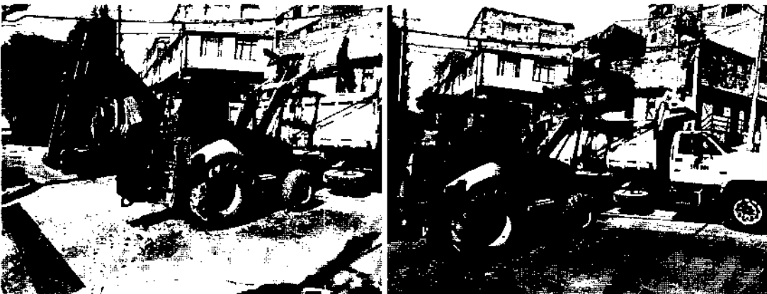
Ilustración 10. TRANSPORTE DE ESCOMBROS CIV 4005352
