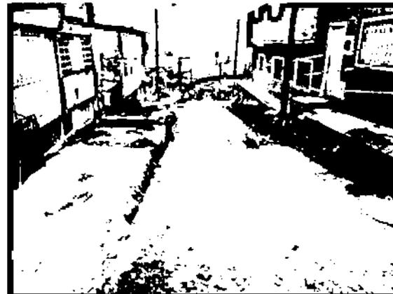
**Ilustración 4. EXTENDIDA Y CONFORMACION DE SUBBASE GRANULAR CLASE C CIV 4007972**
