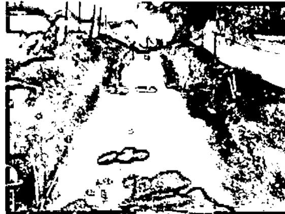
**Ilustración 3. EXTENDIDA Y CONFORMACION DE SUBBASE GRANULAR PEATONAL CIV 4005079**
