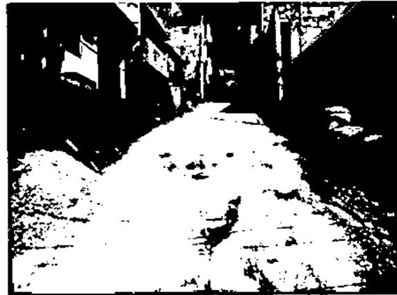
Ilustración 2. EXTENDIDA Y CONFORMACION DE SUBBASE GRANULAR CLASE C CIV 4005073
