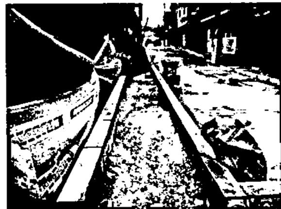
**Ilustración 8. INSTALACION DE BORDILLOS PREFABRICADOS A-80 CIV 4005352**
