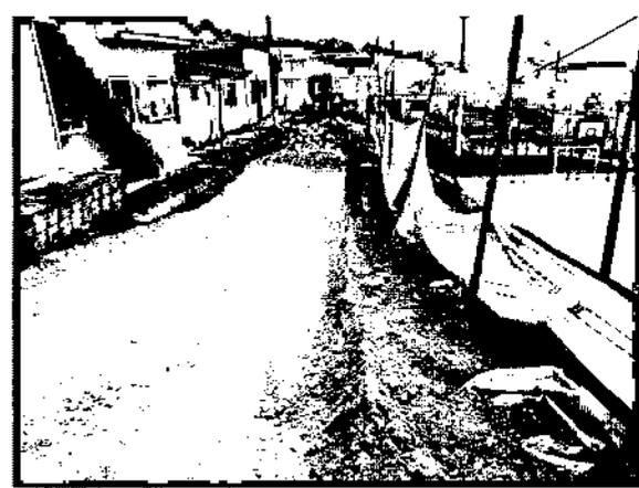
**Ilustración 31. EXTENDIDA Y CONFORMACION SUBBASE GRANULAR CLASE C CIV 4007971**
