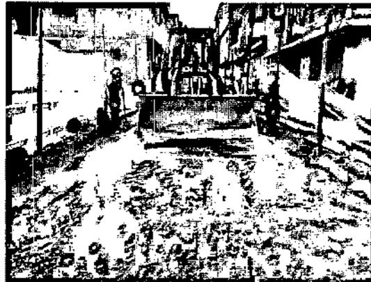
**Ilustración 28. EXTENDIDA Y CONFORMACIÓN DE SUBBASE GRANULAR**
