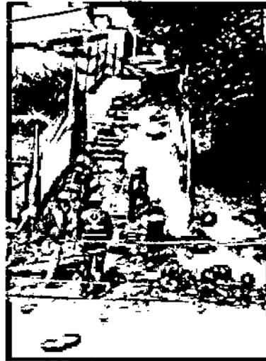
**Ilustración 16. DEMOLICION DE ESCALERAS EN MAL ESTADO**
