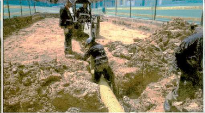
Descripción: Instalación de tubería de 16". CIV 4000577, Frente de obra 2.
