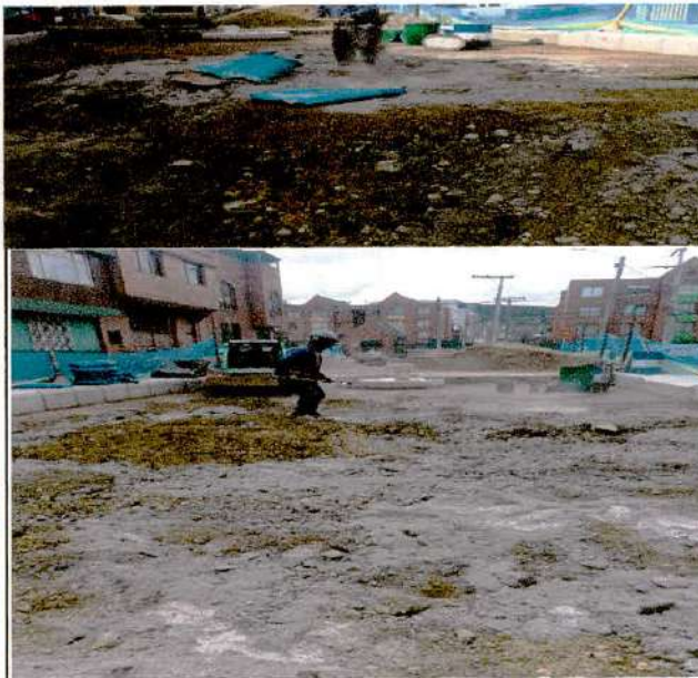
Descripción: Instalación de base granular BG_A . CIV 4000755, Frente de obra 1.
