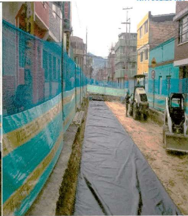
Descripción: Instalación de geotextil CIV 4000577, Frente de obra 2.
