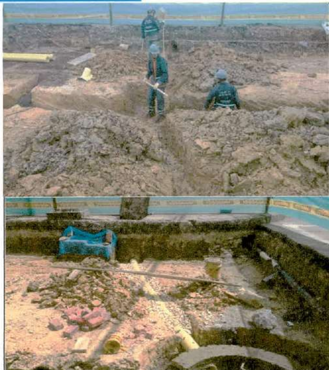
Descripción: Instalación de tuberías de 6" para sumideros existentes CIV 4000577, Frente de obra 2.
