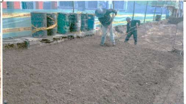
Descripción: Reparación de fallos que se presentaron en la capa de subbase granular CIV 4000577, Frente de obra 2.
