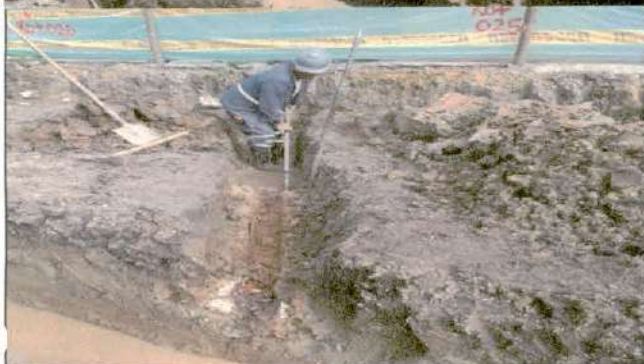
Descripción: Excavación y demolición de redes existentes . CIV 4000755, Frente de obra 1.
