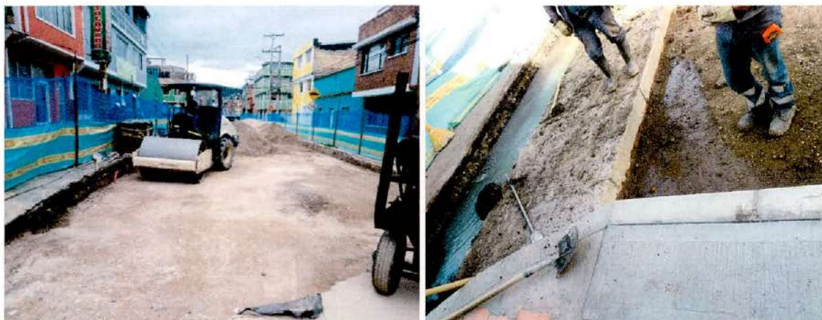
Imagen 12. Nivelación sub-base; Fundición de andenes, Frente 1 - CIV 40000755.
