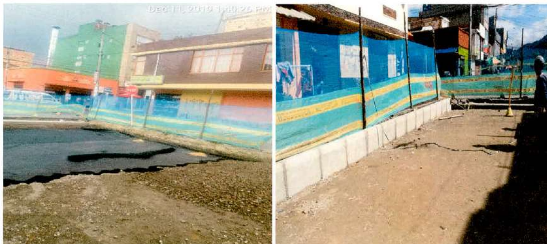
Imagen 11. Instalación geotextil y sardineles, Frente 1 - CIV 40000755.
