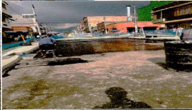
Descripción: Instalación de emulsión asfáltica . CIV 4000755, Frente de obra 1.
