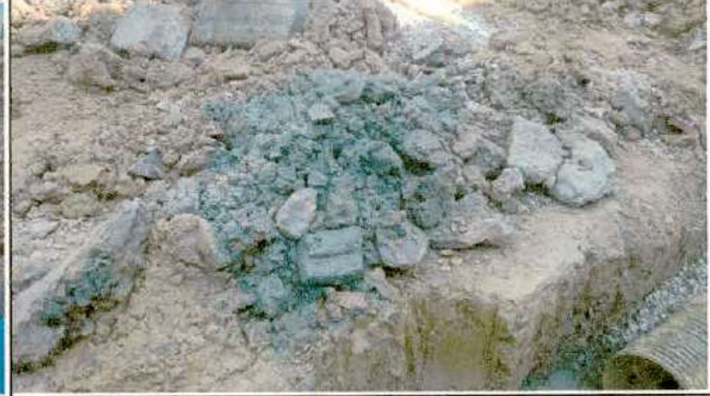
Descripción: Demolición y retiro de concreto de la red de alcantarillado principal. CIV 4000577, Frente de obra 2.
