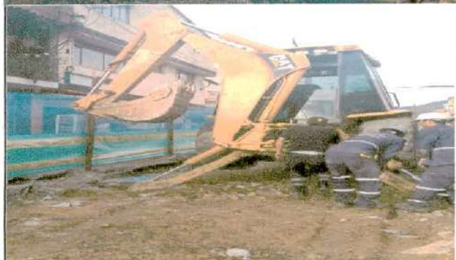
Descripción: Excavación mecánica hasta de nivel de subrasante. CIV 4000755, Frente de obra 1.
