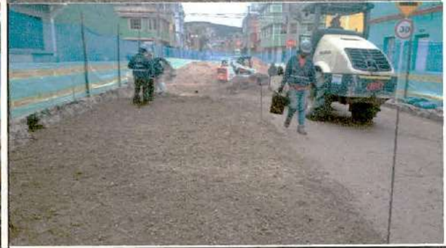
Descripción: Extendido, compactación y humectación de base granular CIV 4000577, Frente de obra 2.
