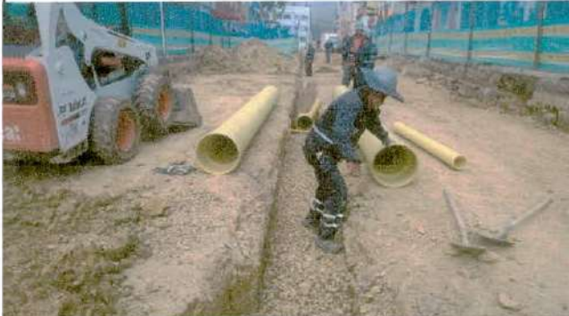
Descripción: Instalación de tubería de 6" para acometidas y sumideros existentes. CIV 4000577, Frente de obra 2.
