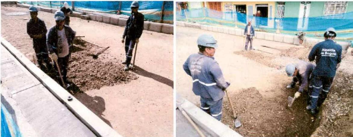
Imagen 16. Excavación, transporte y disposición de material; compactación y nivelación de subrasante (de izquierda a derecha), Frente 2 - CIV 40000577.
