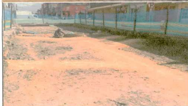
Descripción: Excavación manual hasta nivel de subrasante. CIV 4000755, Frente de obra 1.
