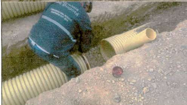
Descripción: relleno de triturado de 3/4" hasta medio tubo de la red principal, Frente de obra 2.
