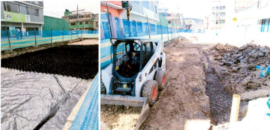
Imagen 15. Instalación geotextil, geocelda y tubería de 16", Frente 2 - CIV 40000577.
