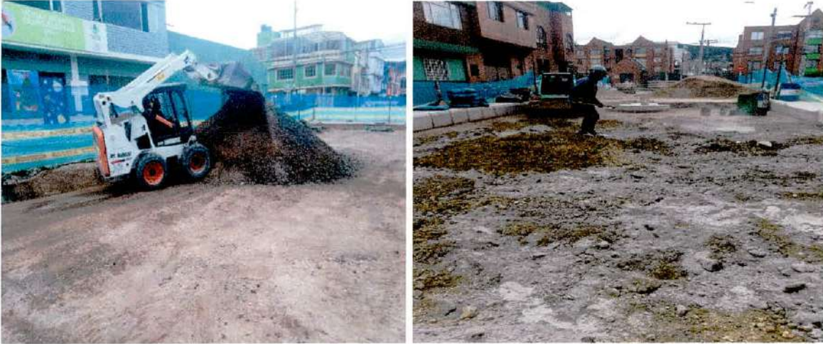
Imagen 13 Instalación base estabilizada, Frente 1 - CIV 40000755
