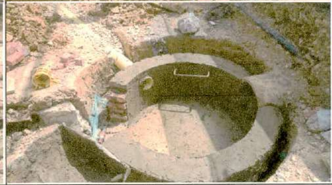
Descripción: Fundición de cilindro para pozo de inspección en mampostería . CIV 4000577, Frente de obra 2.
