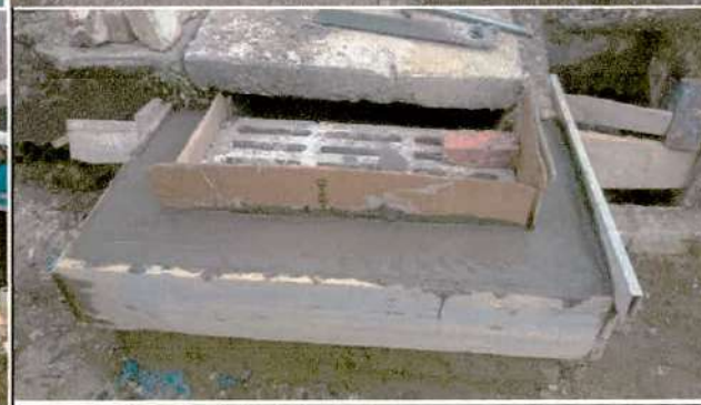
Descripción: Nivelación de sumideros existentes CIV 4000577, Frente de obra 2.
