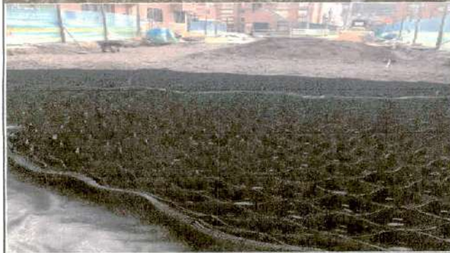
Descripción: relleno de geoceldas con subbase clase b reciclada. CIV 4000755, Frente de obra 1.
