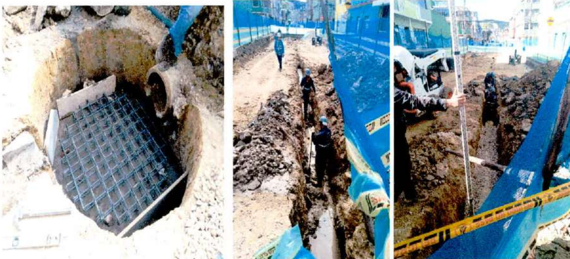
Imagen 14. Figurado de acero e instalación de tubería de 16", Frente 2 - CIV 40000577.
