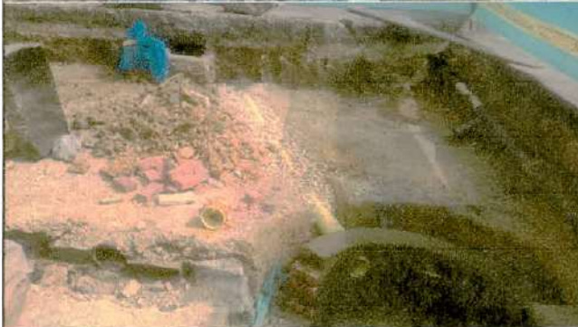
Descripción: Instalación de tubería de 6" para acometidas y sumideros existentes. CIV 4000577, Frente de obra 2.
