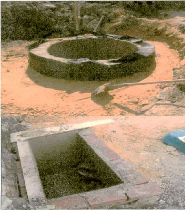
Descripción: Construcción de pozos y sumideros. CIV 4000755, Frente de obra 1.
