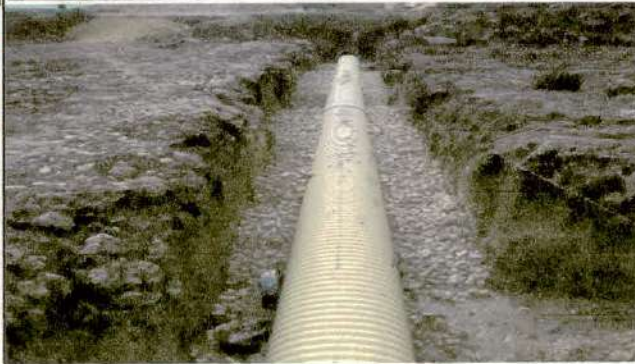
Descripción: Instalación de tubería de 12" y 8". CIV 4000755, Frente de obra 1.
