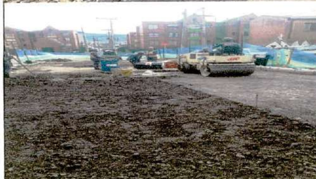
Descripción: Se realiza compactación de la base estabilizada . CIV 4000755, Frente de obra 1.
