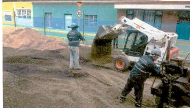
Descripción: mezclado de base granular con reciclado de concreto CIV 4000577, Frente de obra 2.
