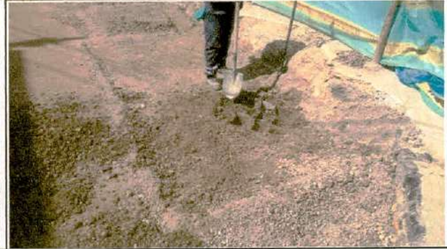
Descripción: Reparación de fallos que se presentaron en la capa de subbase granular CIV 4000577, Frente de obra 2.
