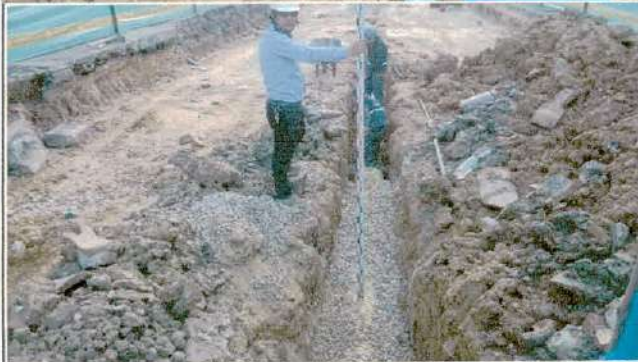
Descripción: Excavación y demolición de redes de alcantarillado. CIV 4000577, Frente de obra 2.
