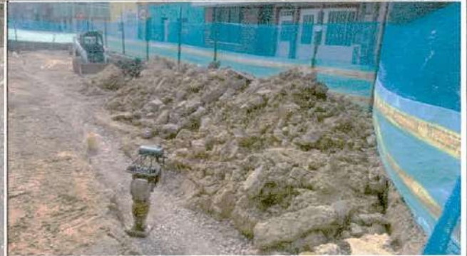
Descripción: relleno hasta nivel de subrasante con recebo. CIV 4000577, Frente de obra 2.
