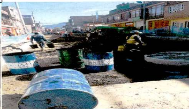
Descripción: Instalación de base granular BG_A . CIV 4000755, Frente de obra 1.
