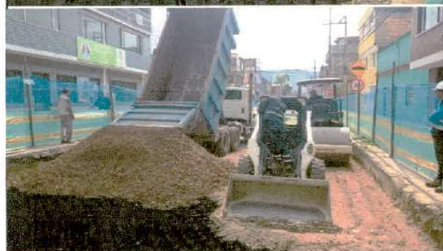
Descripción: Mejoramiento de subrasante mediante la instalación de geocelda CIV 4000577, Frente de obra 2.
