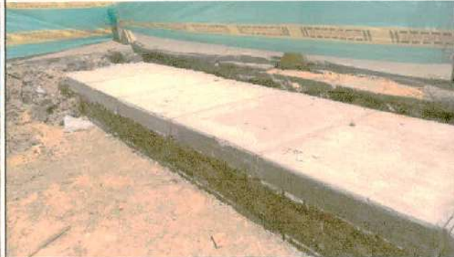
Descripción: Construcción de carcamo para red de ETB. CIV 4000755, Frente de obra 1.
