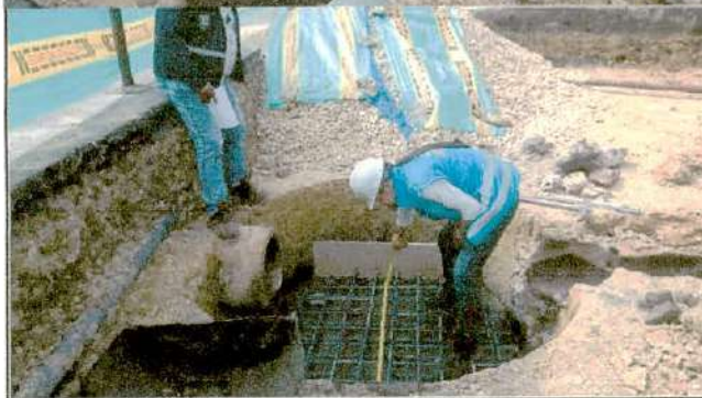
Descripción: Excavación y nivelación de pozo de inspección . CIV 4000577, Frente de obra 2.
