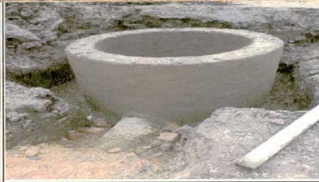
Descripción: Excavación mecánica hasta nivel de subrasante, cargue y disposición del material. CIV 4000755, Frente de obra 1.
