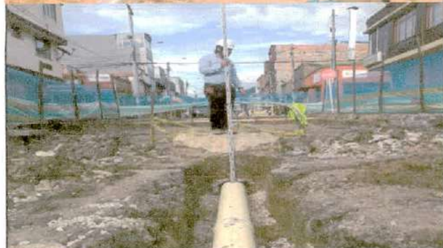
Descripción: Nivelación y seguimiento a las actividades de excavación. CIV 4000755, Frente de obra 1.
