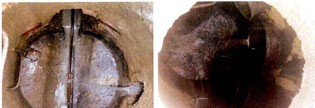
Imagen 7. Limpieza e inspección de pozos CIV 4001475 y 4001485
