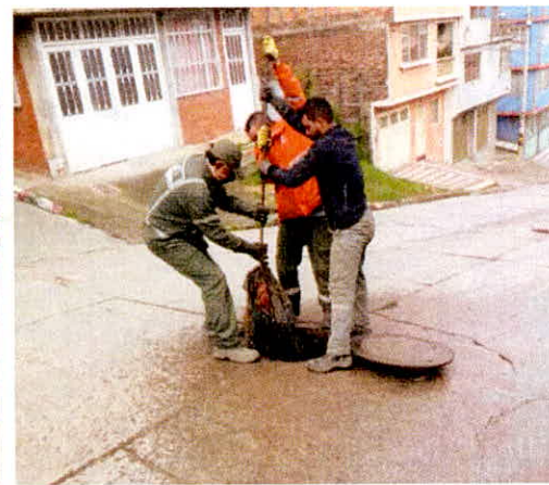
Imagen 6. Limpieza de tuberías con equipo Vector CIV 4007400
