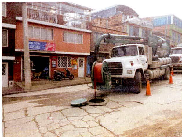
Imagen 6. Limpieza de tuberías con equipo Vector CIV 4007400
