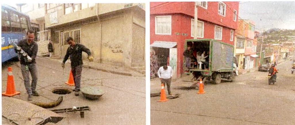
Imagen 8. Inspección de redes con CCTV CIV 4000990 y 4001052
