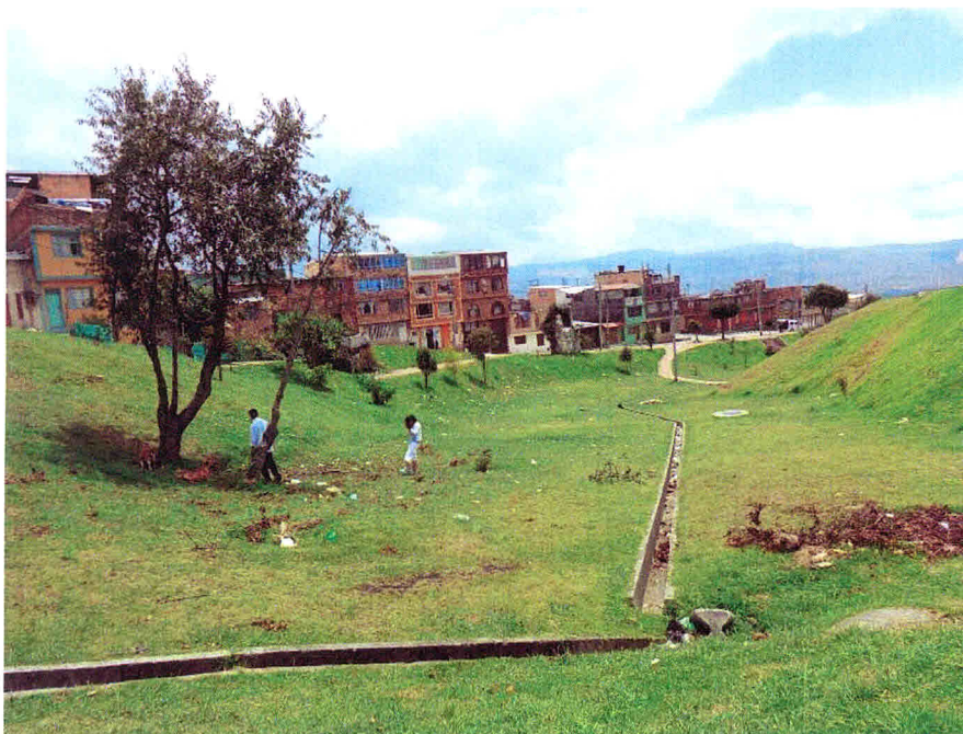
Figura 22. Cuenca quebrada Chorro Colorado
