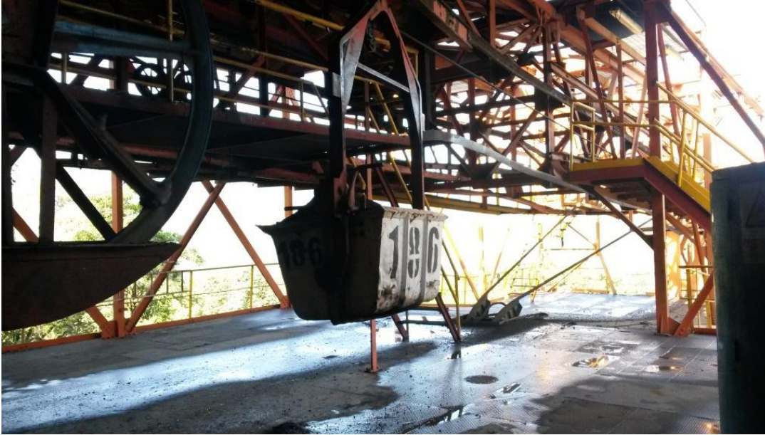
Teleférico Ternium para transporte de materiales (México)
