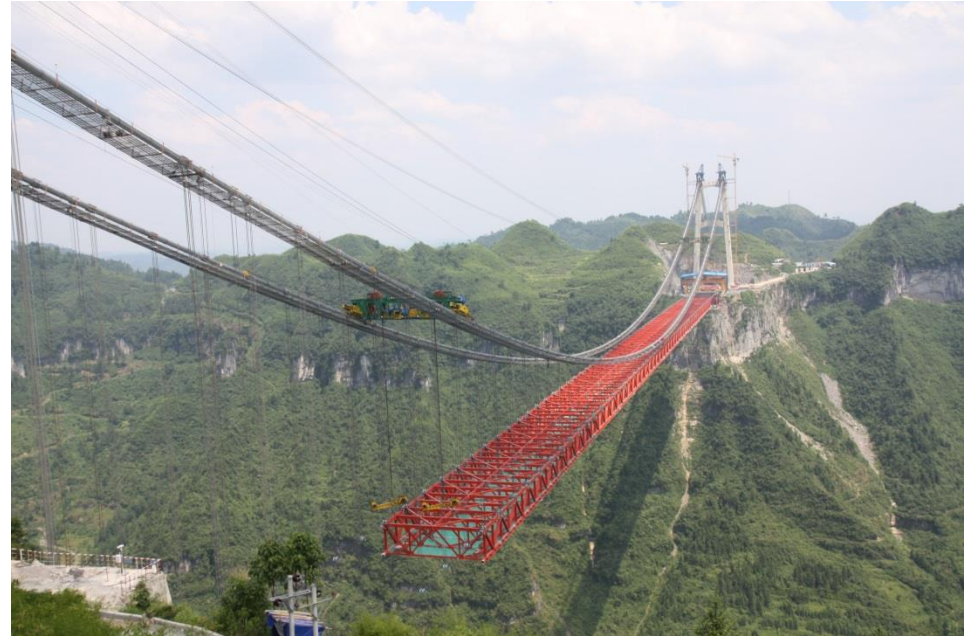
Blondin para la construcción de un puente
