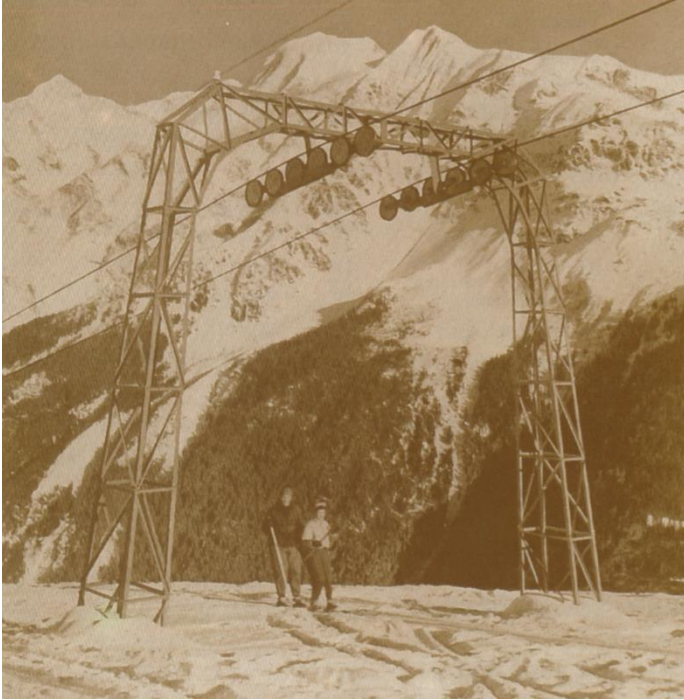
Torre en pórtico de un telesquí de percha doble y enrolladores en la estación de esquí de Les Contamines-Montjoie
