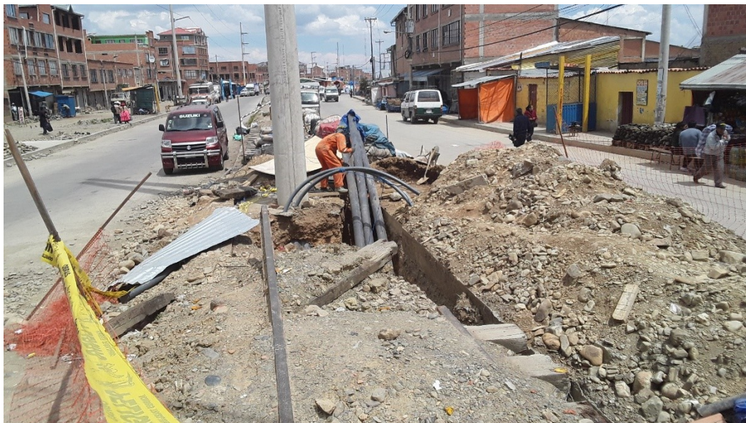
Figura 76 - Soterrado red AT 115Kv por interferencia con sistema Mi Teleférico La Paz Fuente: Archivo equipo de consultoría contrato 1630 de 2020
