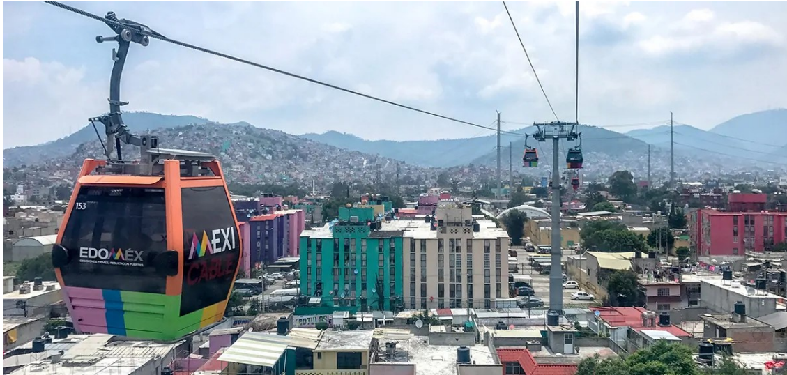
Figura 73 - Cruce sistema MEXICABLE con líneas 85Kv y 230kv Fuente: https://local.mx/ciudad-de-mexico/mexicable-teleferico-ecatepec/ - 4 de abril de 2021
