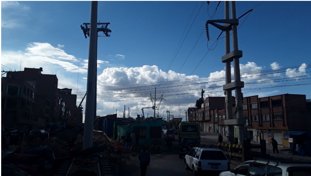
Figura 75 - Interferencia red AT 115Kv con línea Morada sistema Mi Teleférico La Paz Fuente: Archivo equipo de consultoría contrato 1630 de 2020
