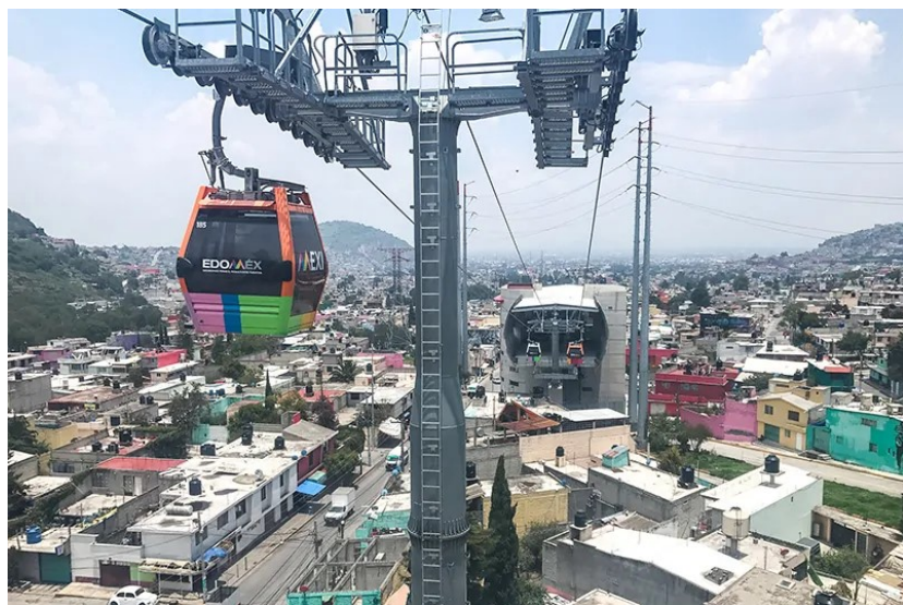
Figura 72 - Cruce sistema MEXICABLE con líneas 85Kv y 230kV Fuente: https://local.mx/ciudad-de-mexico/mexicable-teleferico-ecatepec/ - 4 de abril de 2021
