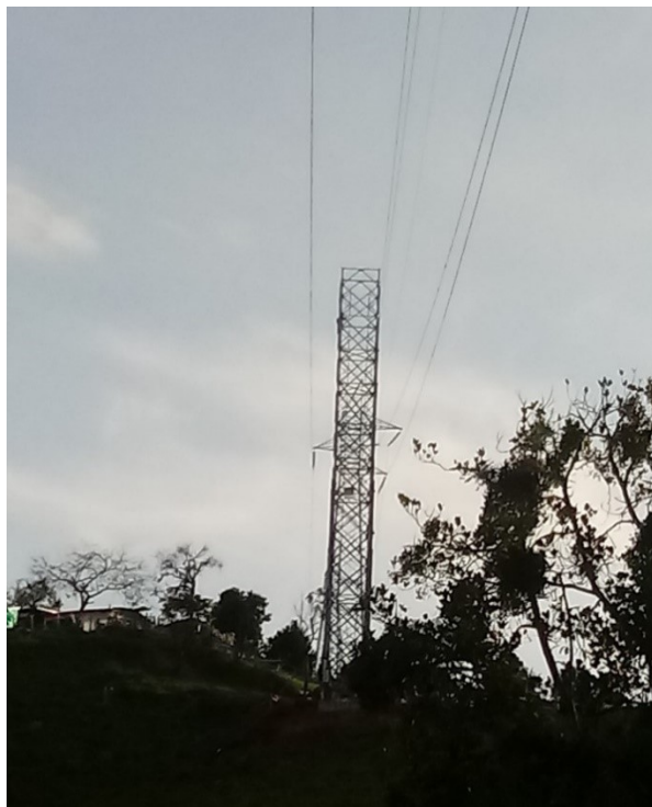
Figura 78 - Apoyo nuevo 60m línea 115kV para realce en cruce con Mega cable-Pereira
