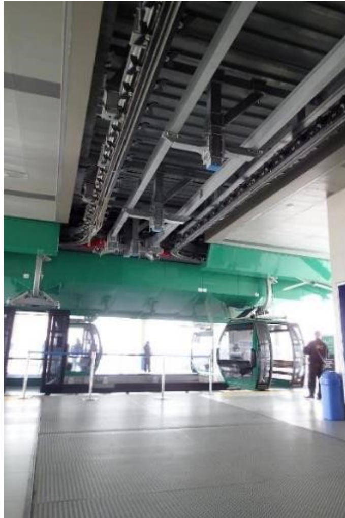
Figura 6-37. Andén retráctil y guías de acceso a garaje. Línea verde Mi Teleférico. La Paz.
