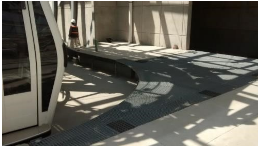
Figura 6-36. Se observa en la imagen, la parte del andén (con rejilla metálica) retráctil que permite el paso de cabinas hacia el almacén.
