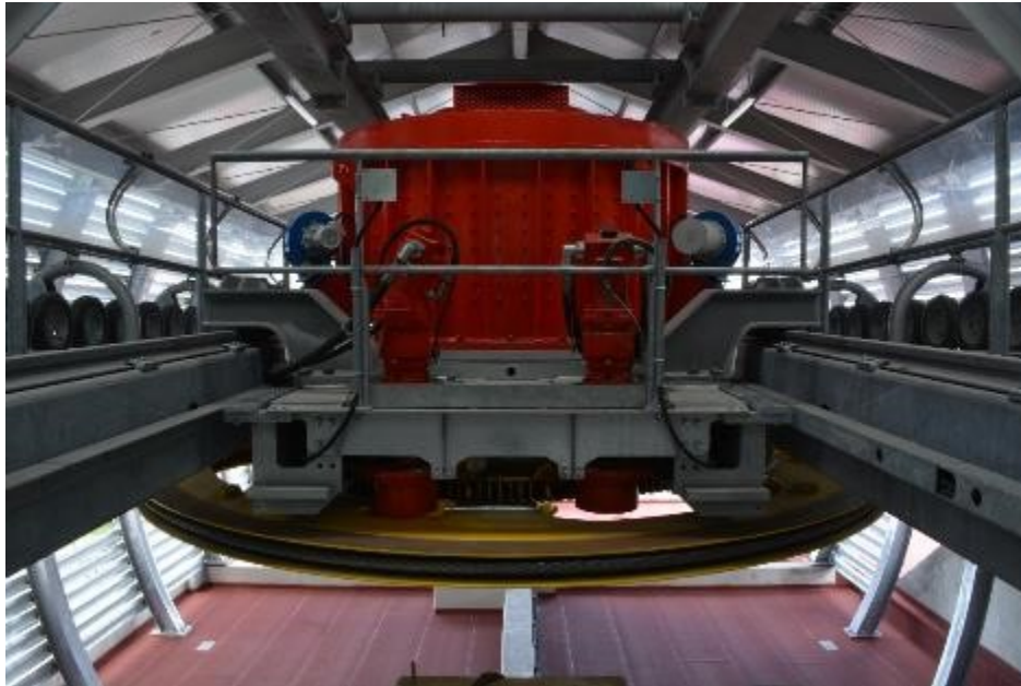
Figura 6-4. Motor directo. Mexicable de Ecatepec.
