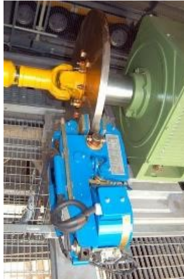
Figura 6-10. Ejemplo de freno de servicio.
