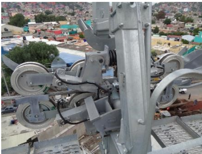
Figura 6-25. Balancín de soporte/compresión. Mexicable de Ecatepec
