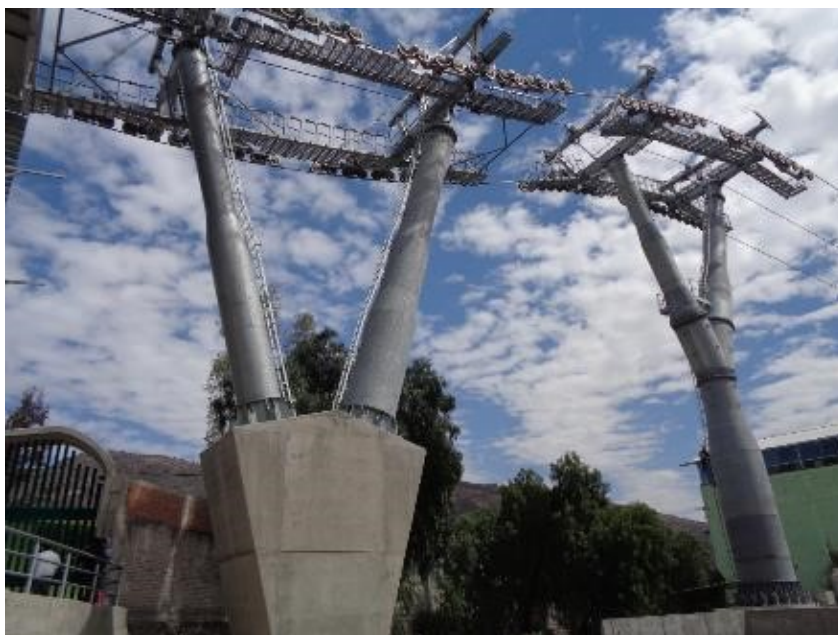
Figura 6-24. Torre doble de compresión (izquierda) y torre en Y (derecha) de soporte. Mexicable de Ecatepec
