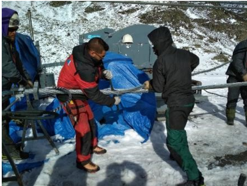
Figura 7-4. Empalme del cable en el telecabina de Tristaina. Andorra
