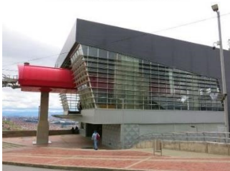
Figura 6-2. Estación motriz del Transmicable de Bogotá integrada en un edificio. La capacidad de transporte de esta instalación es de 3600 pphd.
