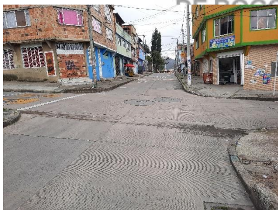
Intersección Carrera 3A Este con Calle 40ASur: Losas recientes en buen estado.
