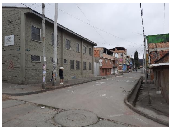
Carrera 3A Este por Calle 40Sur: Juntas abiertas aunque la losas se hallan en buen estado. Andenes deprimidos.
