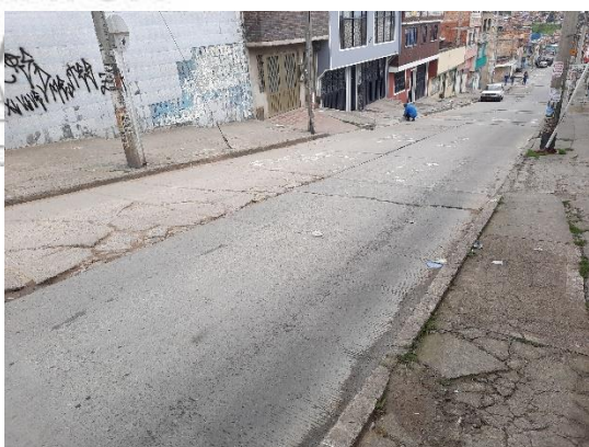
Calle 41Sur entre carreras 3A Este y 3C Este: Losas subdivididas, andenes amplios pese al mal estado de su capa de rodadura.
