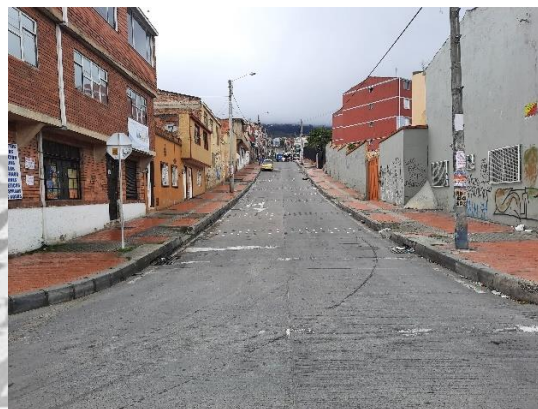
Andenes amplios, provistos de adoquines de arcilla y una franja en loseta podotáctil, que ofertan buen estado.
