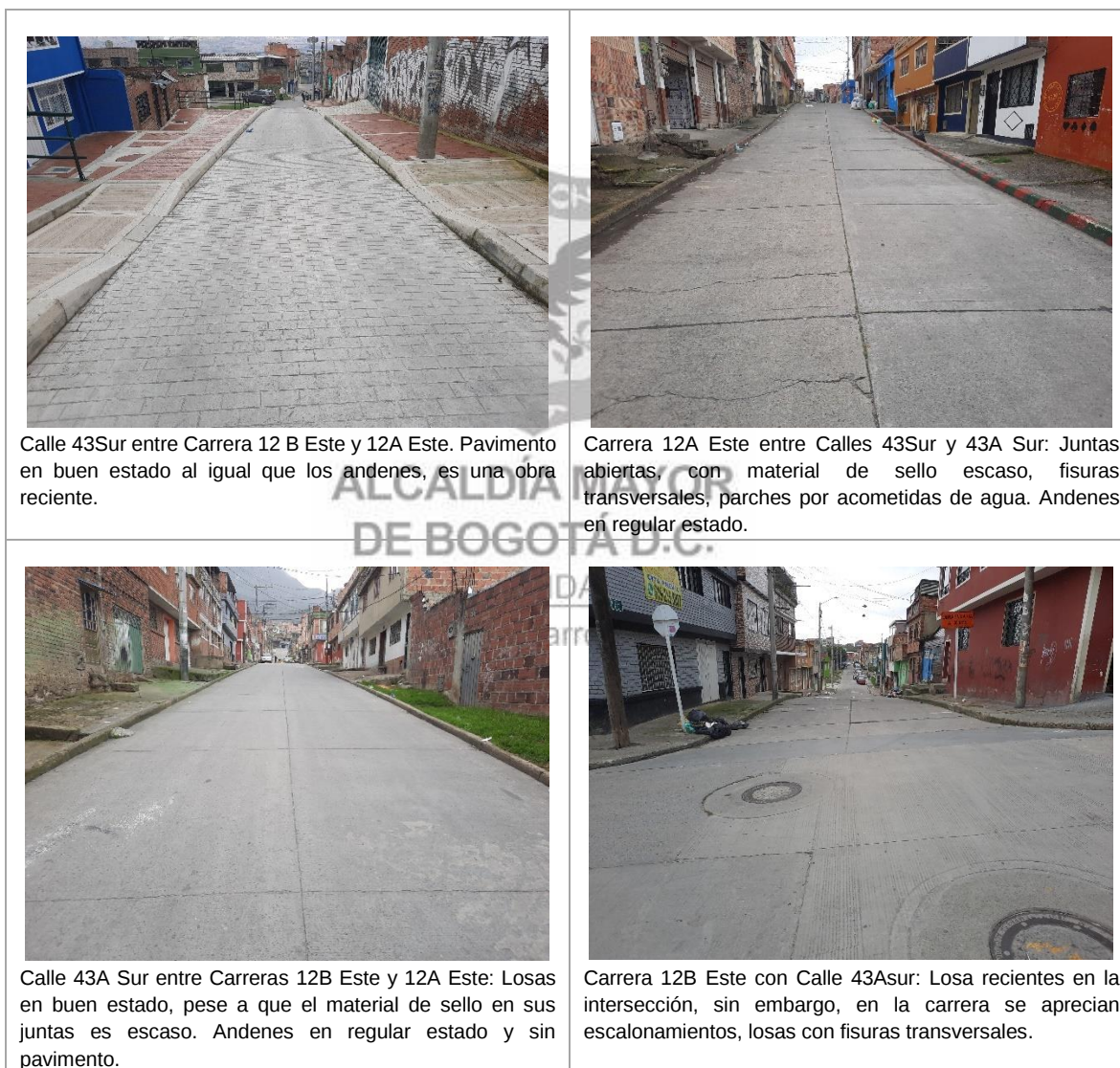
Figura 3-3 Reporte Fotográfico sector Altamira.
