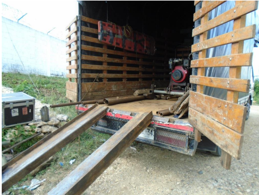
Figura 8. Descargue del equipo de perforación y herramientas
