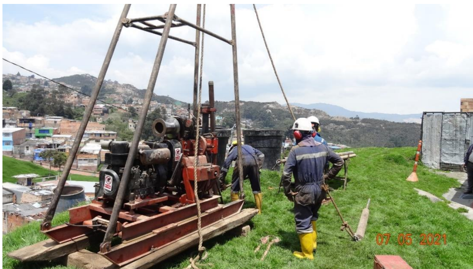
Figura 9. Operación del equipo de perforación
