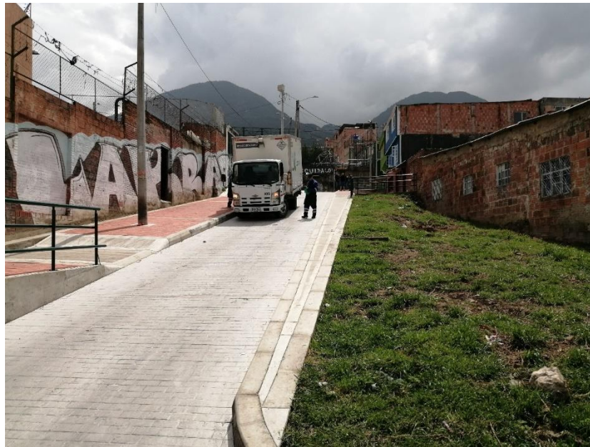
Figura 162. Estado actual andén opuesto Calle 42b Sur entre Carreras 12a y 12b Este
