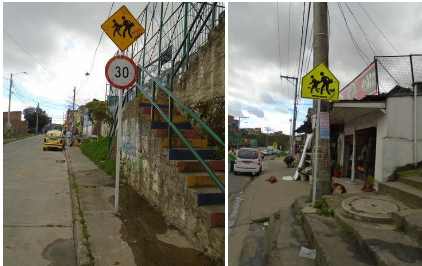
Fotografía 7. Infraestructura peatonal Carrera 12b Este (izq) y Avenida Carrera 13b Este (der)
