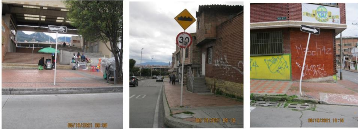
Fotografía 14. Estado de señalización en el AII
