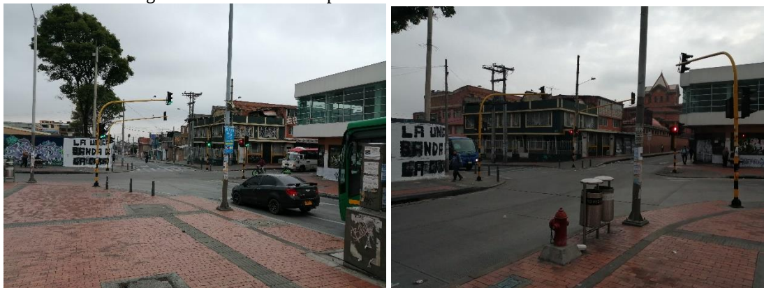
Fotografía 7. Infraestructura peatonal existente Carrera 5a – Calle 30a Sur
