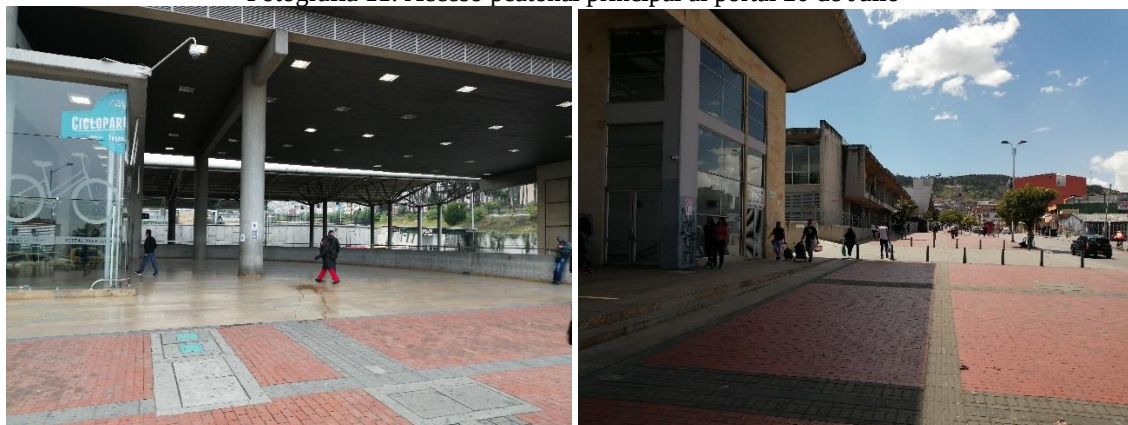
Fotografía 11. Acceso peatonal principal al portal 20 de Julio
