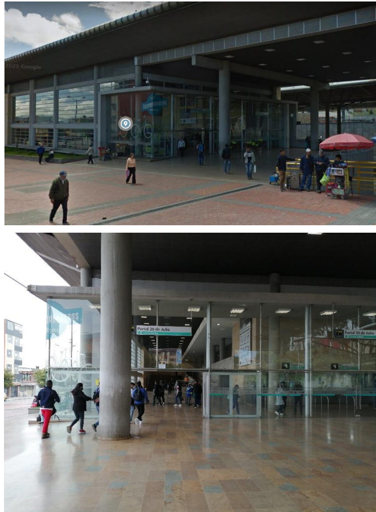
Fotografía 19. Ciclo parqueaderos Portal 20 de Julio
