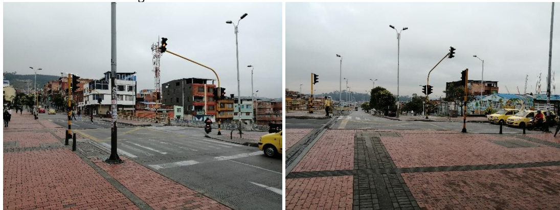
Fotografía 17. Señalización existente Carrera 5a – Calle 31 Sur
