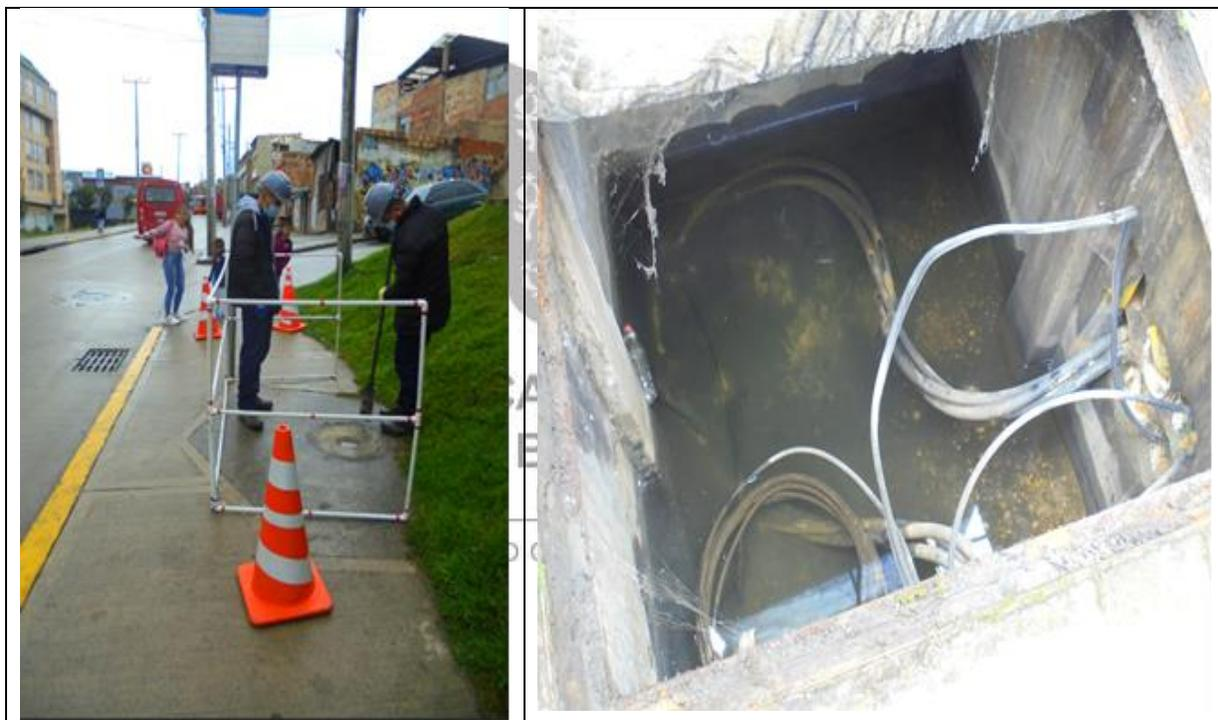
*Imagen- 3 – Levantamiento de cajas externas e internas*
