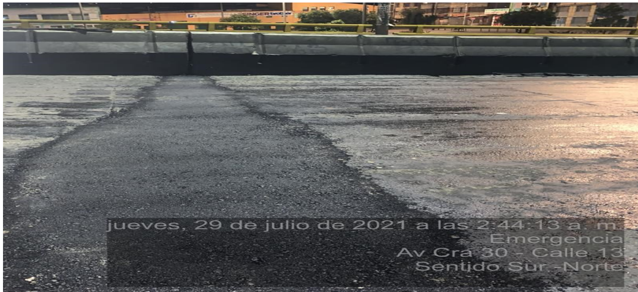
Foto 1: Estado actual tablero puente Avenida Ciudad de Quito por Avenida Centenario
