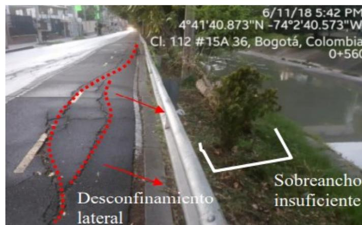
Actualmente la ciclovia presenta fallas en su estructura, como fisuras longitudinales, fisuras en media luna e inestabilidad en banca, fallas que afectan la seguridad de los usuarios de dicha infraestructura, las cuales son producidas por un efecto denominado como desecación.
