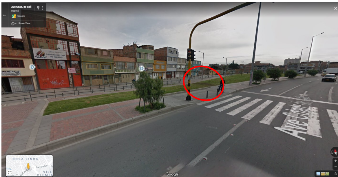
Vista del separador afectado por paso de bicitaxis y otros vehículos
