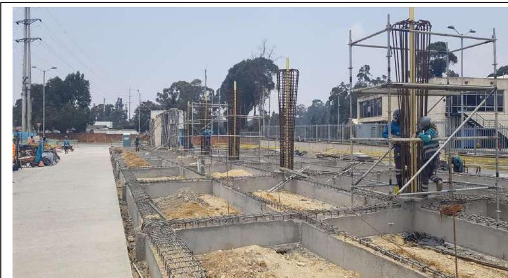
**FOTOGRAFÍA No.0 2.** Se observa el estado de obra en actividades no registradas como ruta crítica, entre otras, las vigas de cimentación y los rellenos previos a la ejecución de la placa de piso.
