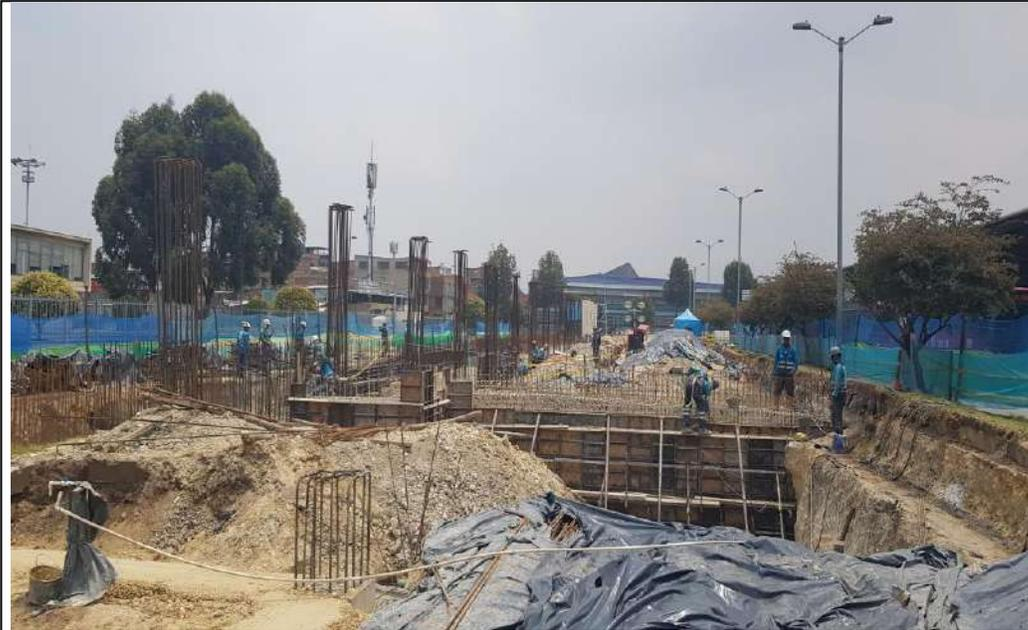
**FOTOGRAFÍA No. 01.** Se observa el estado de obra en actividades atrasadas no registradas como ruta crítica, entre otras la cimentación, asociada con los rellenos. De igual manera, se observa el estado de atraso de las columnas de sección variable, las cuales, de acuerdo con la programación vigente al 9 de marzo/2020, deberían tener un avance del 79%.
