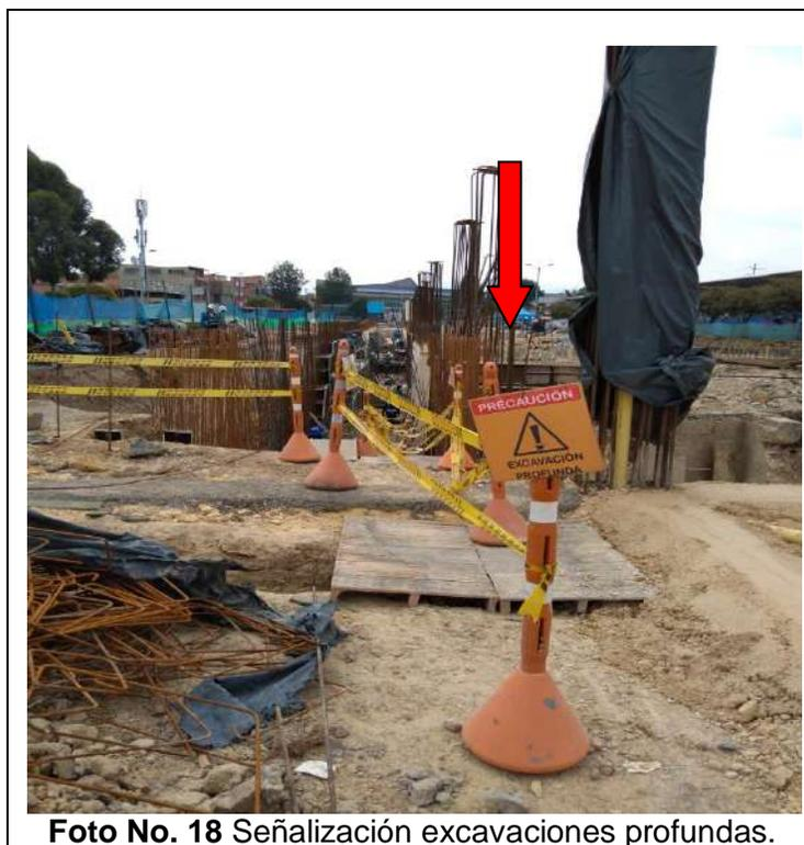
Foto No. 18 Señalización excavaciones profundas.
