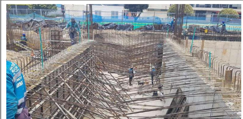
**FOTOGRAFÍA No. 3.** Se observan otros aspectos de actividades atrasadas que no se registran como ruta crítica, tales como los muros en concreto reforzado en el sector del box culvert.
