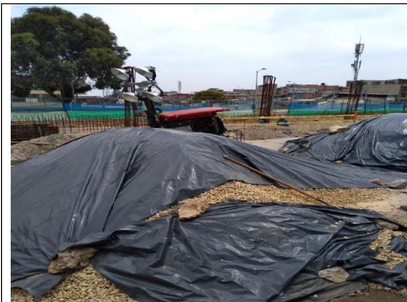
**Foto No. 11** Acopio temporal, parcialmente cubierto y sin señalización.
