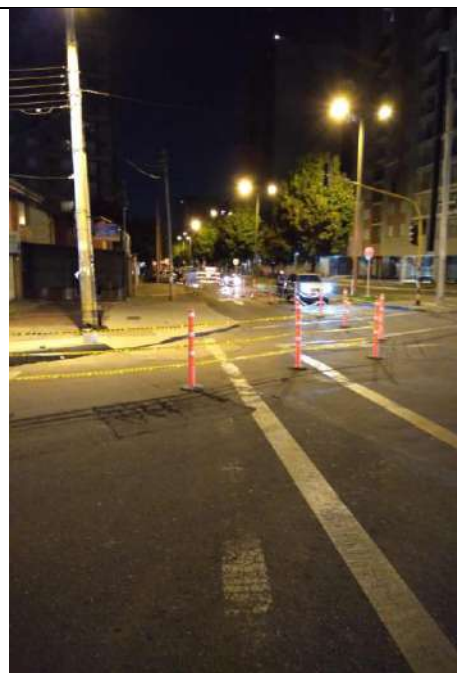
Foto N.º 21. Frente de obra: Avenida Carrera 9 con calle 147.
