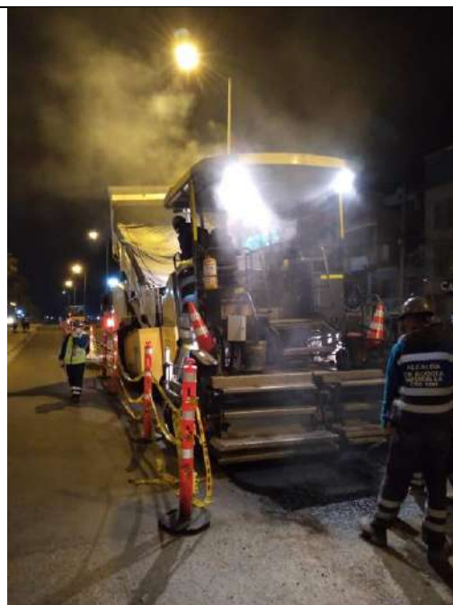
Foto N.º 22. Frente de obra: Avenida Santa Fe (carrera 95A) entre Calle 63 Sur y Calle 75 Sur.
