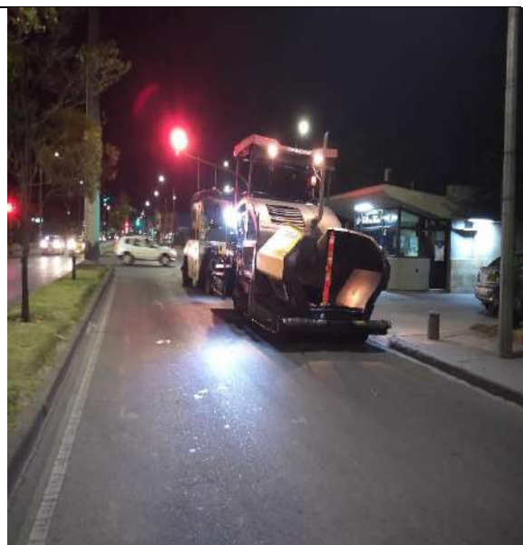
Foto No. 14 Movimiento de Maquinaria.
