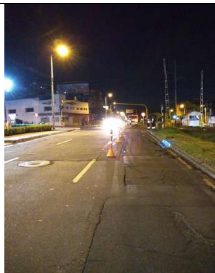
Foto N.º 20. Frente de obra: Emergencia: Carrera 9 con calle 140.
