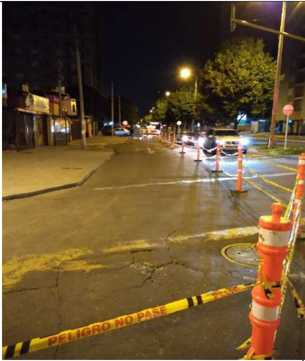
Foto No. 8 Implementación cerramiento.
