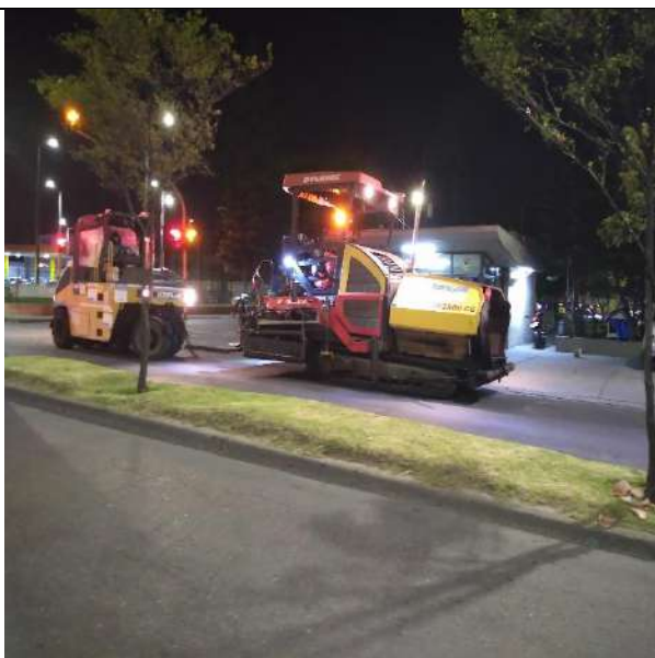
Foto No. 13 Maquinaria sin escolta
