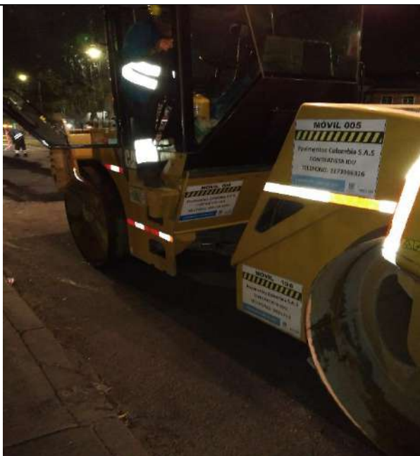
Foto No. 11 Vibrocompactador Caterpillar CB-534D.
