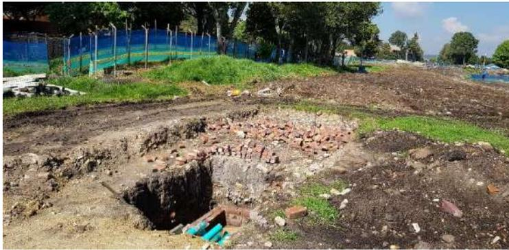
En algunos sectores o puntos específicos de los frentes de obra visitados, en los cuales se ha realizado excavación, se identificó que está pendiente la colocación de la señalización correspondiente, conforme lo establece el Manual de Seguimiento Ambiental para estos casos.
