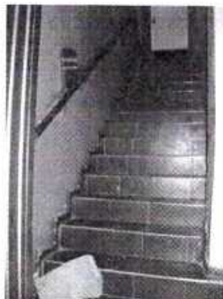
ESCALERA AL PISO TRES
