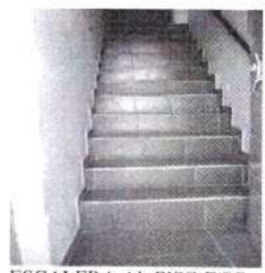
ESCALERA AL PISO DOS
